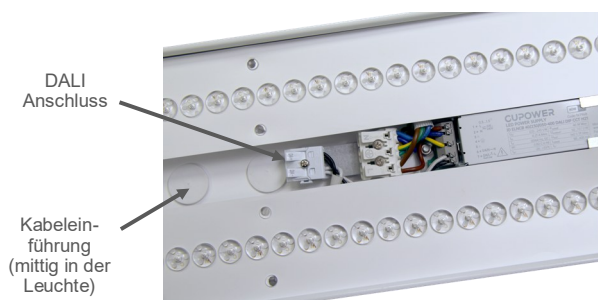
1. Anschlussklemme mit Zugentlastung
